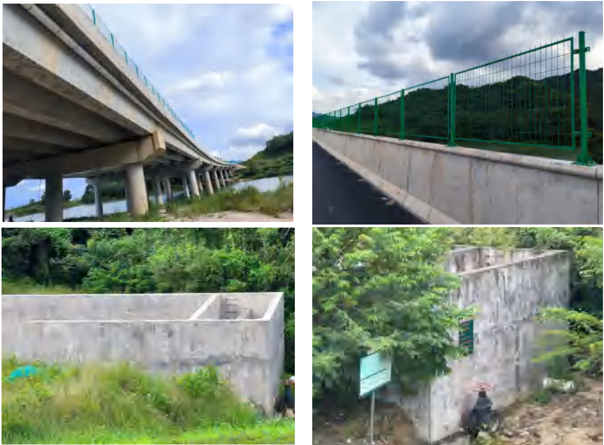
图 9.3-1 独坝大桥桥面径流收集与事故应急池现场图
