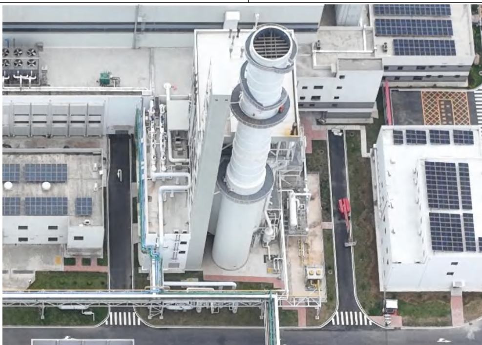
1#余热锅炉排气筒 DA001
