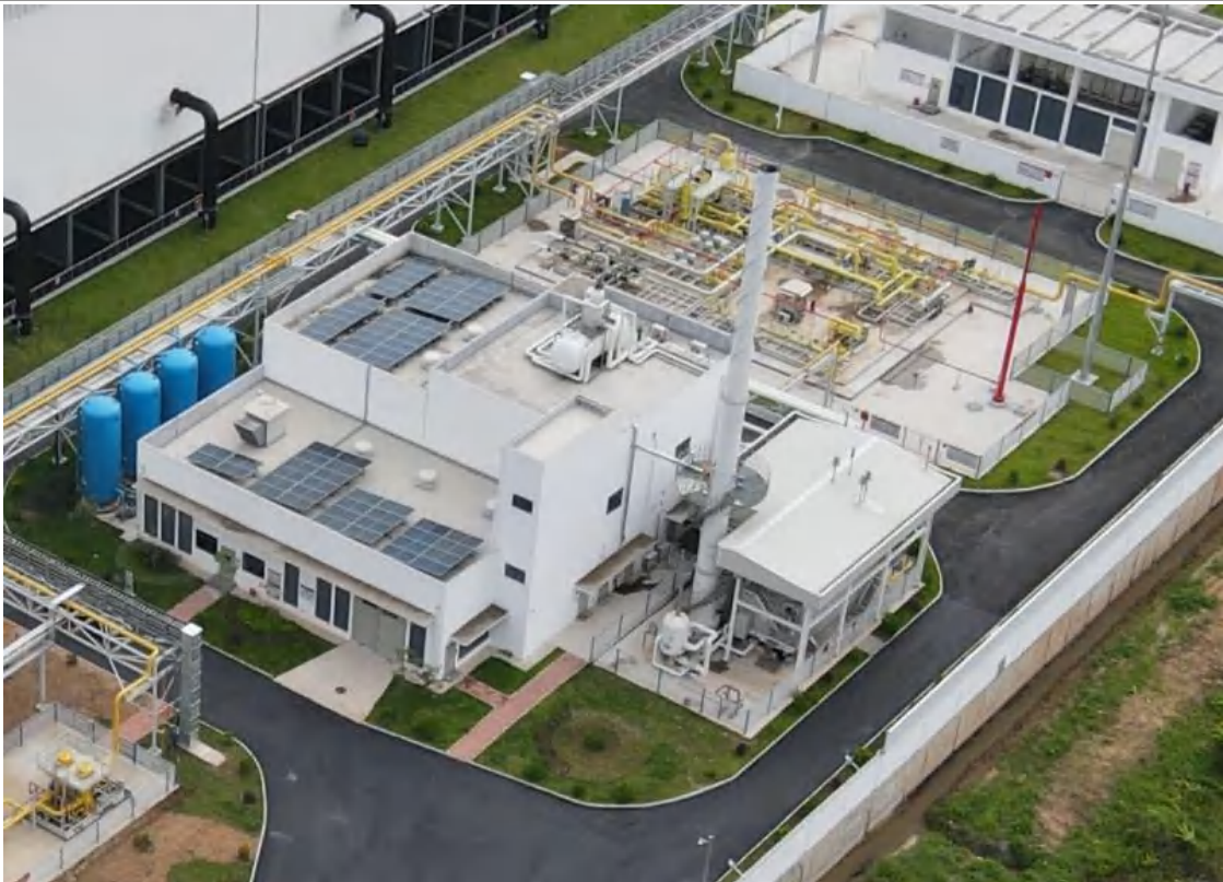
启动锅炉排气筒 DA003
