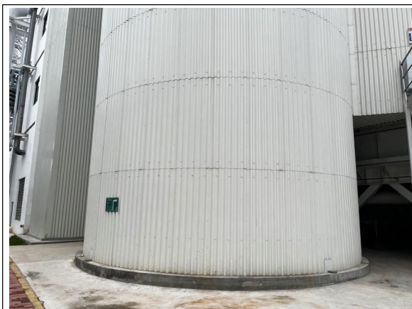
1#余热锅炉排气筒 DA001
